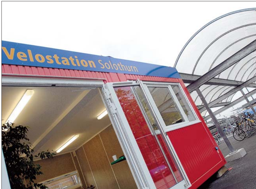
VORERST NOCH IM CONTAINER Das Velostations-Provisorium hat bald einmal ausgedient, wenn alles glatt läuft, sollen die 197 bewachten Abstellplätze im nächsten Sommer in der Bahnhofunterführung zu finden sein. MADDALENA TOMAZZOLI HUBER
