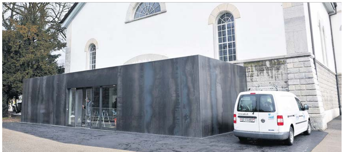
ENDE IN SICHT Die Toilettenanlage bei der Reithalle wird nächste Woche eröffnet. OLIVER MENGE
