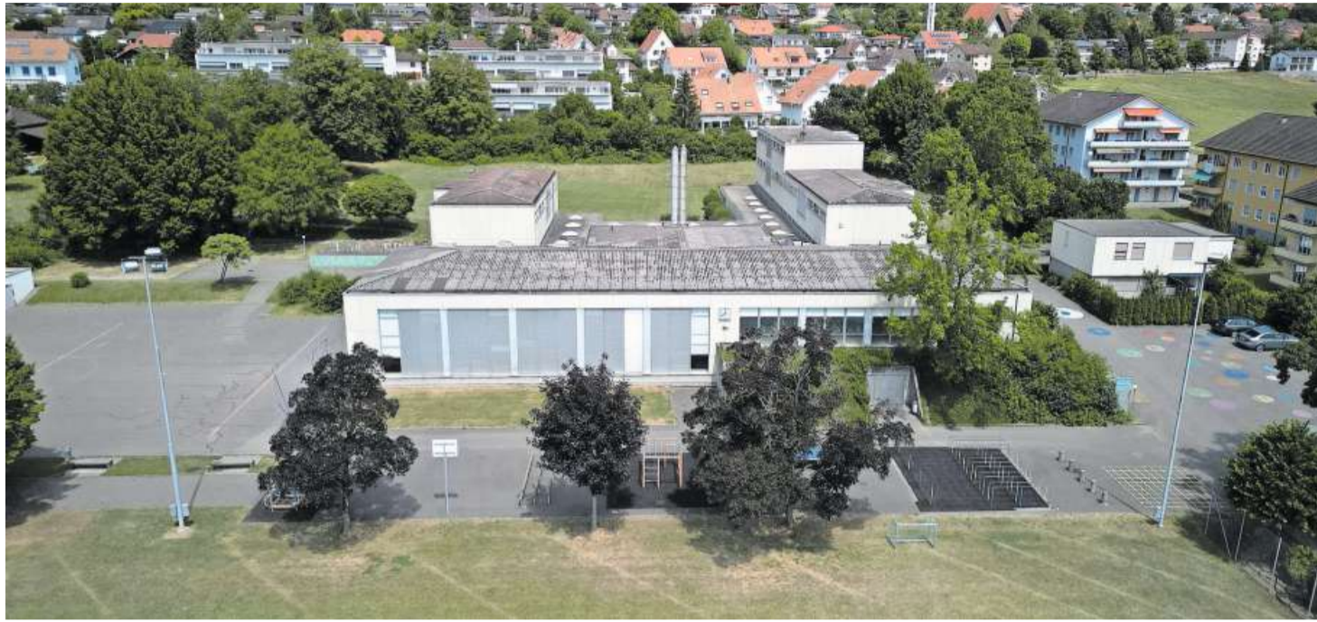
Das Schulhaus Einschlag Bettlach wird vorerst nur mit einer zusätzlichen Turnhalle erweitert.
